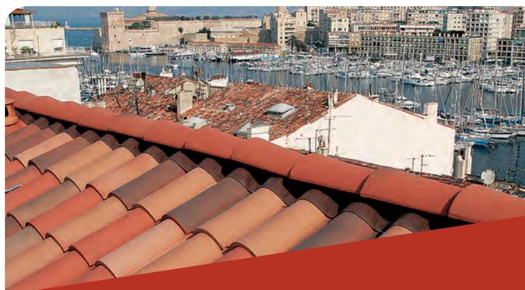
≈ 10/m<sup>2</sup> / Section de ventilation à l'éégout 300 cm<sup>2</sup>/ml
