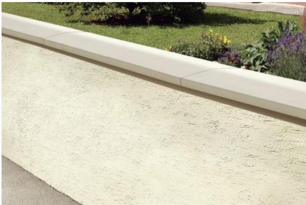
Chaperons à Deux Pentes de finition lisse et rectifiée pour avoir une grosseur uniforme sur l'ensemble de la pièce. Leur section à double pente facilite l'évacuation de l'eau.
