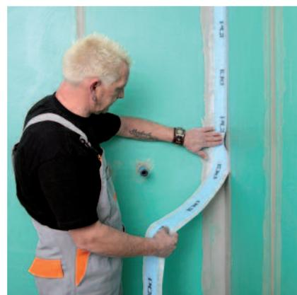
On étale ensuite la bande d'étanchéité spéciale PCI Pecitape 120 à la main et on la presse légèrement...
