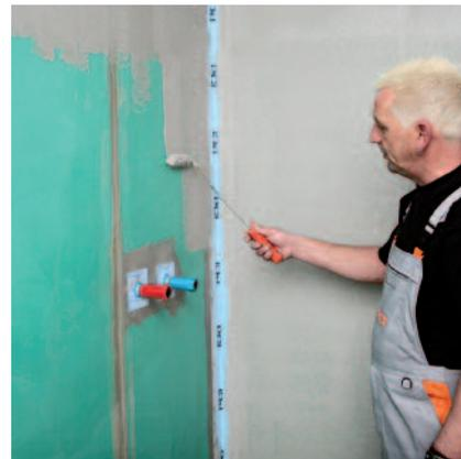
Lorsque les détails ont été réalisés, on effectue l'étanchéité de surface avec le matériau d'étanchéité respectif
