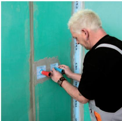
...puis on tire la manchette d'étanchéité prudemment sur le bouchon, sur la pièce de prolongement et on l'incorpore dans le matériau d'étanchéité frais.
