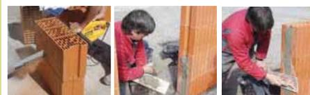
Le harpage de l'OPTIBRIC PV impose que l'opérateur coupe une brique sur deux. Cette coupe est facilitée par le sens des alvéoles et s'effectue à la hachette ou à la scie crocodile ou à la disquesuse à eau.
