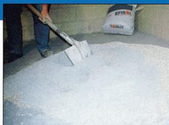
Préparation manuelle du béton VERMEX.
