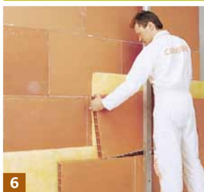
**6** Réaliser, pour chacune des 2 cloisons, une désolidarisation périphérique à l'aide d'une bande résiliente caoutchouc. Après avoir monté la 1<sup>ère</sup> cloison, plaquer la laine de verre et monter la 2<sup>ème</sup> cloison.
