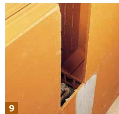
**9** Le montage du CARROBRIC de 15 cm est réalisé systématiquement au liant colle maçonnerie. Le CARROBRIC de 15 cm offre la possibilité d'incorporer des armatures verticales et horizontales, ainsi que des poteaux d'angles. Le CARROBRIC de 15 peut être utilisé en extérieur. De plus, son classement en catégorie A permet l'utilisation d'enduits lourds, y compris monocouche. Réserve : **9** - Chaînage horizontal : **10** - Poteaux d'angles : **11**.
