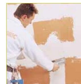
Les joints sont traités sur une grande largeur. Ils sont exécutés au liant colle à l'aide d'un platoir ou d'un couteau. Dans le cas d'un revêtement épais (CARROFEU), carrelage... ils seront simplement coupés au séchage.
