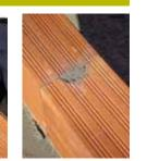
La mise en œuvre doit être conforme aux prescriptions du DTU 20.1. Déposer Les briques sont posées jointives, la gorge donnant automatiquement le mortier sur la face lisse de la brique. L'épaisseur finie du mortier entre deux l'emplacement du joint vertical. Les joints sont réalisés par remplissage des gorges.
