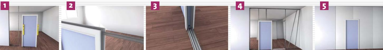
**1** Montage du châssis **NAVIBLOC** porte intégrée sur l'ossature acier de 48 mm.
