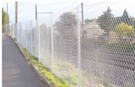
Clôture Simple Torsion avec piquet Té galvanisé
