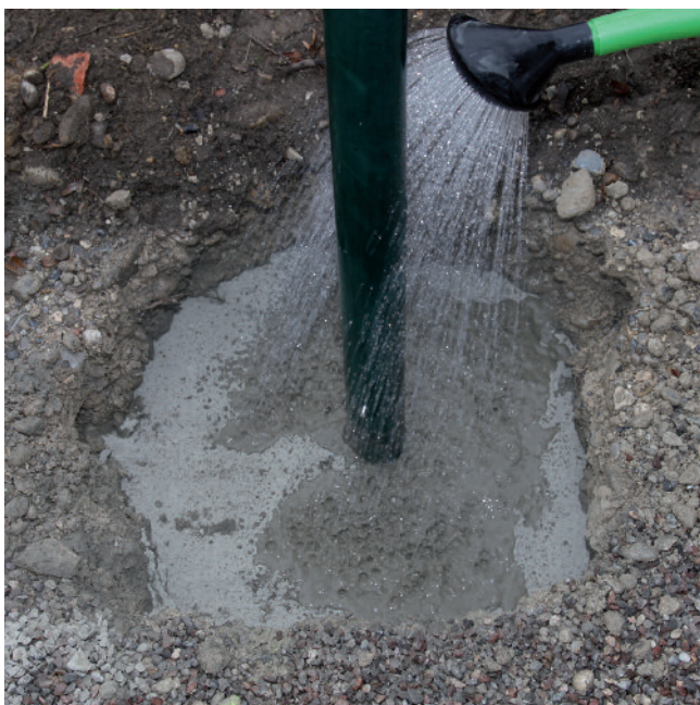
3. Etaler le PCI Pavifix FFM dans l'ensemble de la cavité et verser de l'eau jusqu'à refus
