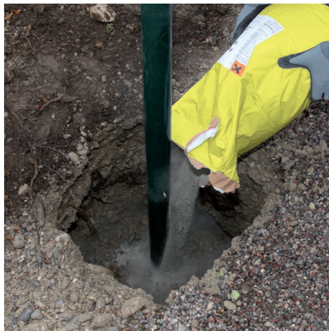
2. Verser le PCI Pavifix FFM en couche de 10 à 15 cm dans l'évidement préalablement mouillé
