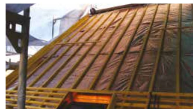
Rénovation de la toiture d'une maison individuelle dans les Hauts de Seine (92)
