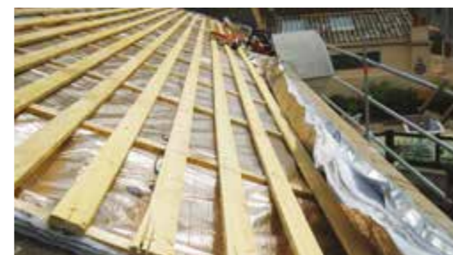
Parois isolées : Toiture par l'extérieur
