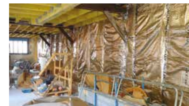
Rénovation d'une habitation à Paris (75)
