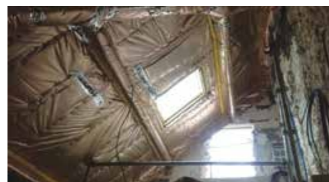
Parois isolées : Toiture par l'intérieur. Murs par l'intérieur en complément de panneaux de SYLVACTIS 40 FX
