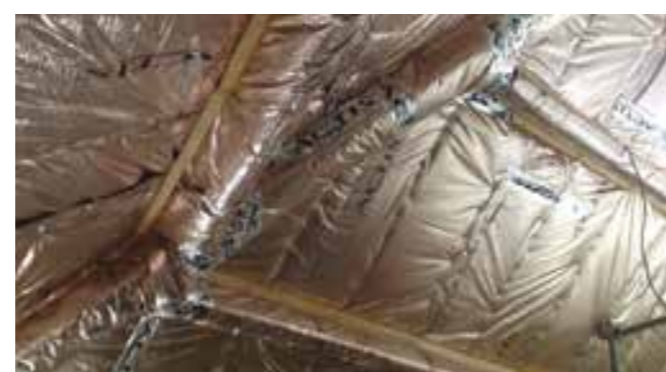
Rénovation d'un immeuble haussmannien à Paris (75)
