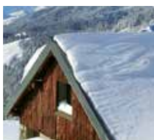
Bâtiment bien isolé
