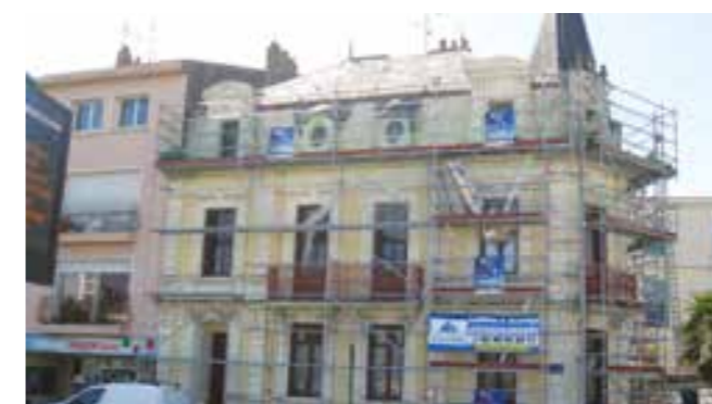
Rénovation d'un immeuble en Vendée (85)
