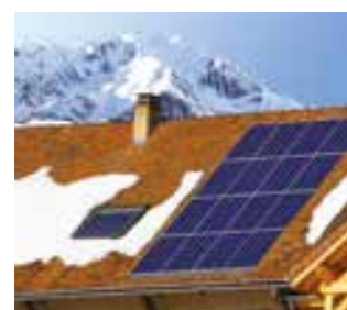
Bâtiment mal isolé
