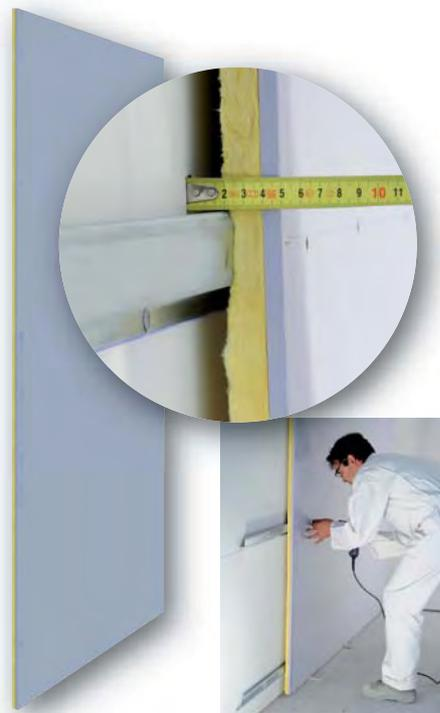
\*\* La solution Placo® Phonique Rénomince® est très performante sur les parois creuses et rayonnantes (briques, carreaux de plâtre, mâchefer...). Elle ne convient pas sur les parois béton > 14 cm.
