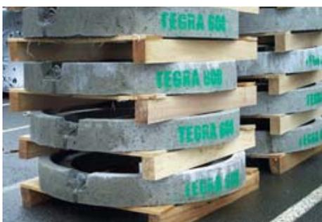
Les couronnes de répartition en béton armé doivent être stockées sur une aire plane et empilées sur 4 hauteurs maximum.
