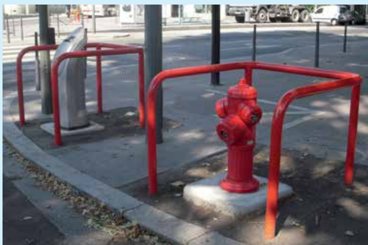
Poteau Rétro protégé du puisage sauvage par une borne de puisage Monéca
