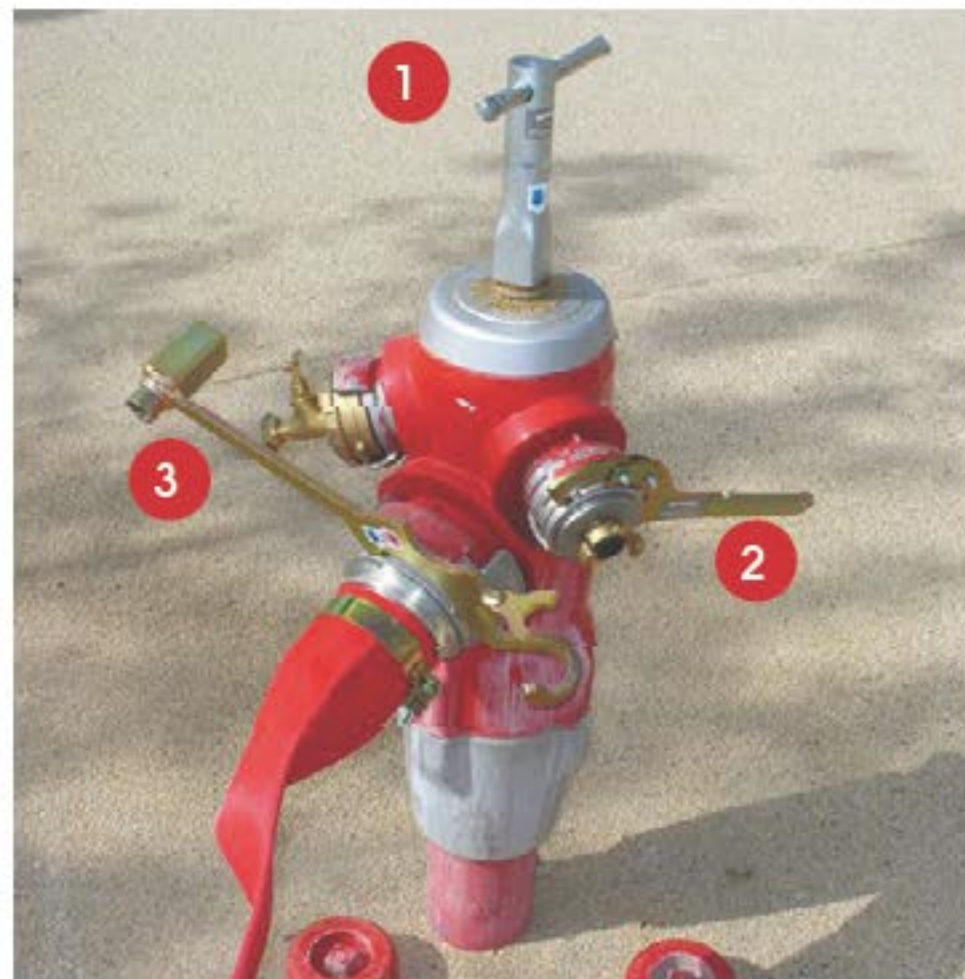
Bouchon bronze DN 65 équipé d'un robinet 20 x 27
