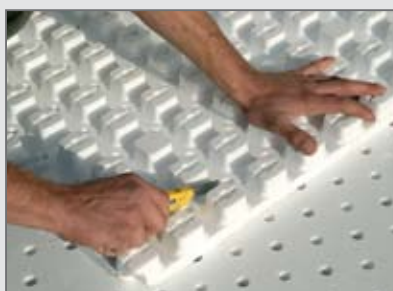
1. Découpe des plaques Knauf Isoldrain
