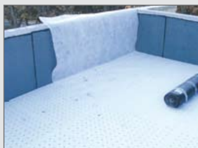
3. Pose de la couche filtrante sur les plaques Knauf Isoldrain
