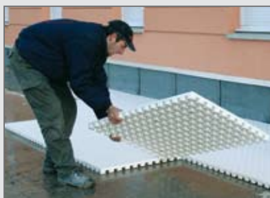
2. Pose des plaques Knauf Isoldrain sur le revêtement d'étanchéité
