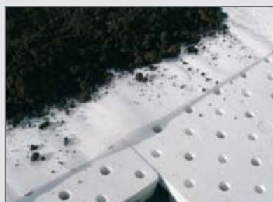
4. Pose de la terre végétale
