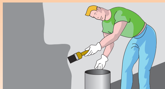
Application de RÉNOLINE FONDEX en 2 couches
