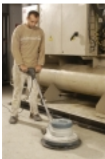
Le local de cette chaufferie située au 5ème étage d'un immeuble lyonnais, a pu être étanché grâce au système PARATHANE : après ponçage soigné du sol, les étancheurs ont appliqué la résine autolissante PARATHANE FLASH en 2 couches.
