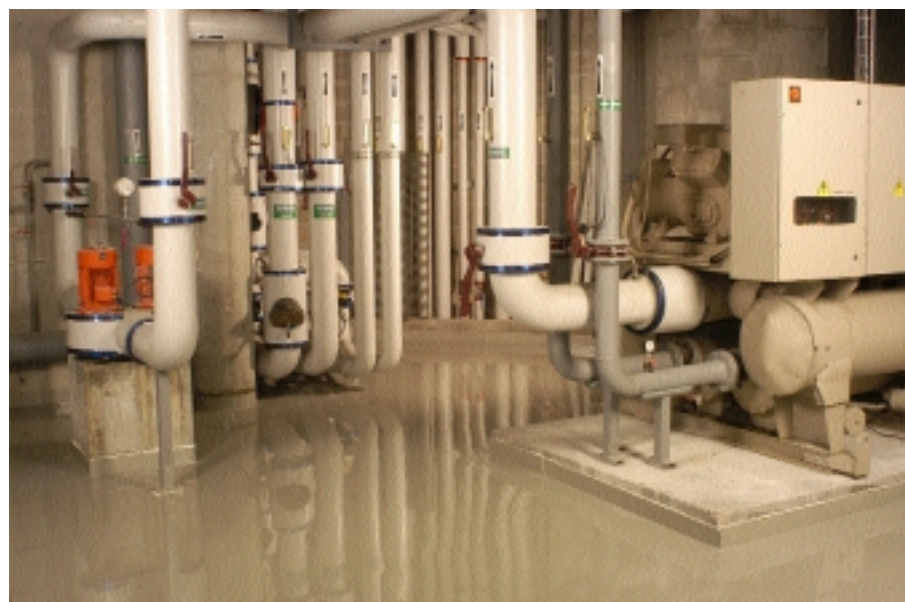
Le local de cette chaufferie située au 5ème étage d'un immeuble lyonnais, a pu être étanché grâce au système PARATHANE : après ponçage soigné du sol, les étancheurs ont appliqué la résine autolissante PARATHANE FLASH en 2 couches.
