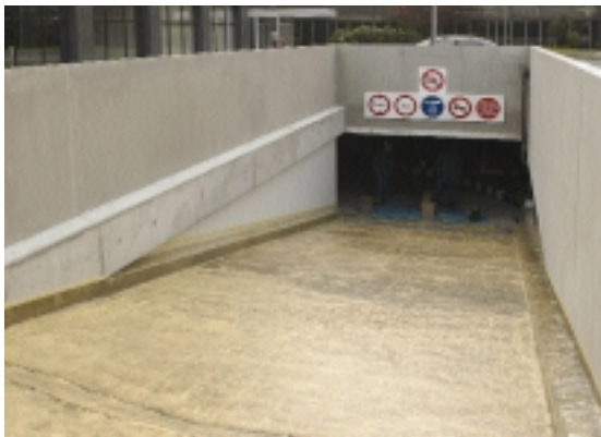
1 - Préparation du support avec PARATHANE PRIMER UNIVERSAL (?)
