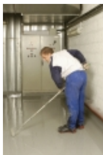
Le local de cette chaufferie située au 5ème étage d'un immeuble lyonnais, a pu être étanché grâce au système PARATHANE : après ponçage soigné du sol, les étancheurs ont appliqué la résine autolissante PARATHANE FLASH en 2 couches.
