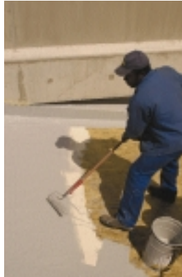
3 - Mise en œuvre au rouleau de la résine d'étanchéité PARATHANE COATING
