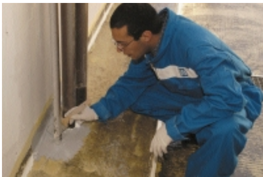
2 - Traitement des points singuliers et réparations éventuelles
