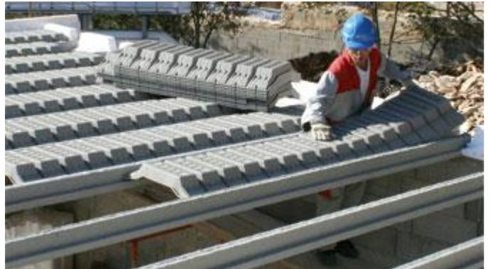
Pour effectuer la mise en oeuvre des entrevous Leader EMS, l'opérateur peut être situé au-dessous ou au-dessus du plancher, ou encore en extrémité de la travée. La mise en oeuvre se fait en 3 temps : 1) poser - 2) clipser - 3) glisser
