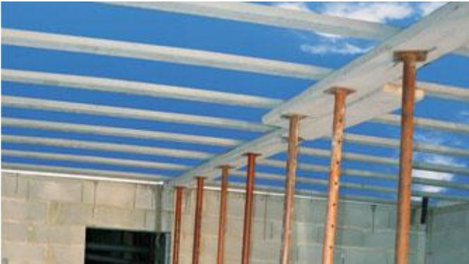
Sauf spécifications écrites sur le plan de pose «pose sans étai», avant de marcher sur les entrevous et les poutrelles, l'étaie doit être mis en place au contact de ces dernières.
