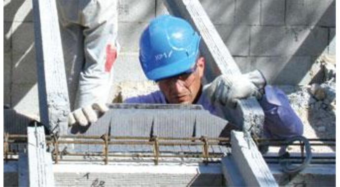
La mise en place des tympan, qui reposent sur les talons des poutrelles, aide au bon positionnement de celles-ci. Les tympan obturent les entrevous et évitent ainsi au béton de couler en sous face du plancher.
