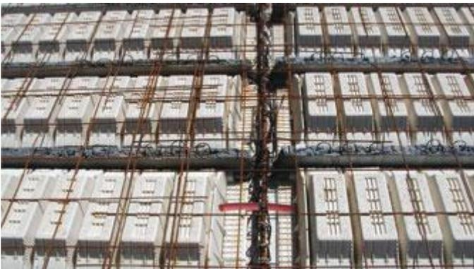
La mise en oeuvre des treillis soudés et du ferrailage complémentaire ( chaînages, chapeaux, renforts, attentes ...) est réalisée de façon traditionnelle.
