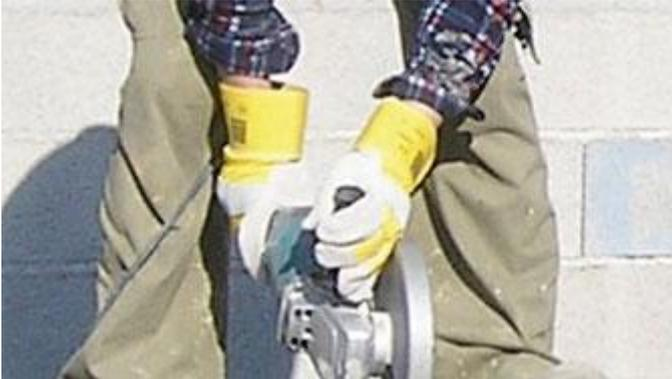
La coupe des entrevous est réalisée à la scie égoïne (denture universelle 5 mm), ou à la disqueuse (disque diamant). Dans le sens de la largeur, la coupe se fait en fond de gorge.
