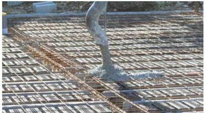
Le coulage de la dalle de compression de 4 cm d'épaisseur se fait avec du béton courant sans excès d'eau. Ne pas couler la dalle si la température extérieure est trop élevée. La bonne étanchéité des entrevous clipsés, associés à des tympons d'abouts, ouvre la possibilité d'utiliser les nouveaux bétons «fluides autonivelants».
