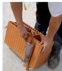
La brique poteau OPTIBRIC PV dispose d'une languette prédécoupée qui permet d'aménager l'emboîtement femelle si nécessaire.
