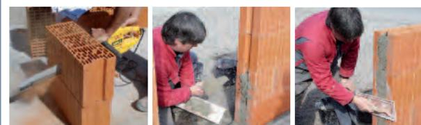
Le harpage de l'OPTIBRIC PV impose que l'opérateur coupe une brique sur deux. Cette coupe est facilitée par le sens des alvéoles et s'effectue à la hachette ou à la scie crocodile ou à la disqueuse à eau.
