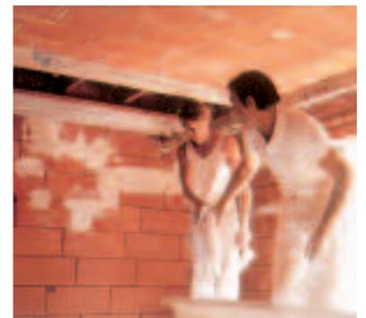
Le réglage du coffrage permettant la mise en place des éléments de plafond suspendu doit être fait en sorte que la planitude finale après décoffrage soit satisfaisante.
