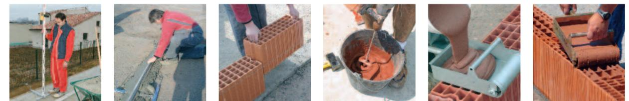
Réalisation du premier rang au mortier traditionnel hydrofugé, à l'aide de platines d'aide à la réalisation de l'arase, Ep 2 cm minimum.
