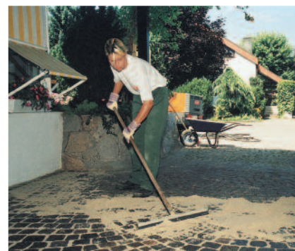
PCI Pavifix 1K est facile à placer et compacter avec un poussoir en caoutchouc et donne une apparence régulière des joints.
